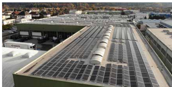
Isolar Isolierglaserzeugung GmbH
